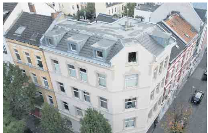
Die Zusammenarbeit mit ausgewiesenen Kompetenzpartnern ermöglichen optimale Dachgestaltungen.
