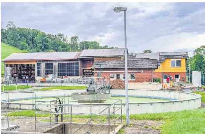
Photovoltaik und Stromspeicher an der Kläranlage Altenbeken
