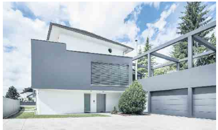
Die Fassade hat nicht nur eine schützende Funktion - sie bildet gleichzeitig das Gesicht des Eigenheims. Foto: djd/Sto/Martin Baitinger
