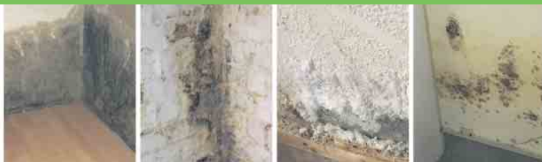
Defekte Horizontalsperre
