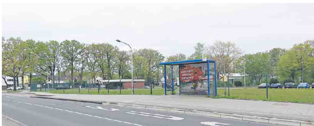
Blick von der Alten Heerstraße auf die Wiesenfläche in der Niederberg-Kaserne, dem Baugrund für die neue Kita. In Bildmitte die Kaserneneinfahrt mit dem Wachgebäude.
