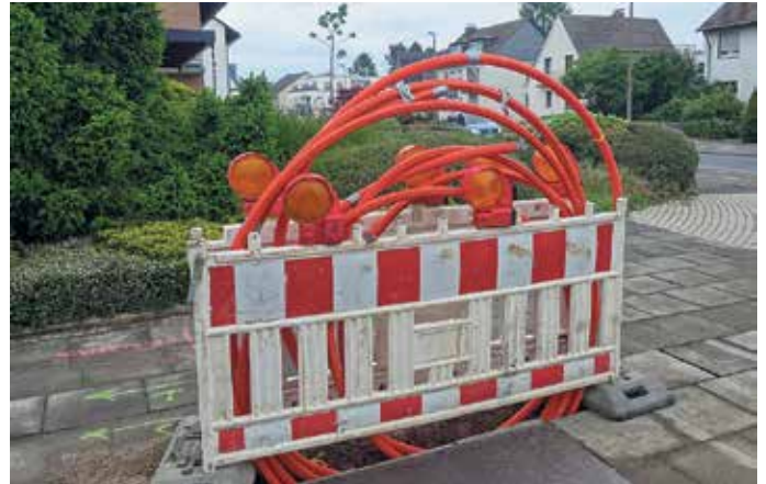
Eine noch nicht fertig gestellte Baustelle der UGG in Menden, schon seit Wochen. Fotos: hdp
