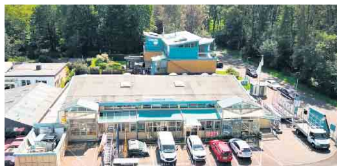
Luftaufnahme vom Betrieb Metallbau Eichwald vom 04.09.2023 (Luftbild: Metallbau Eichwald)
