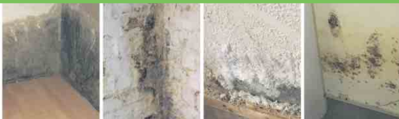
Defekte Horizontalsperre
