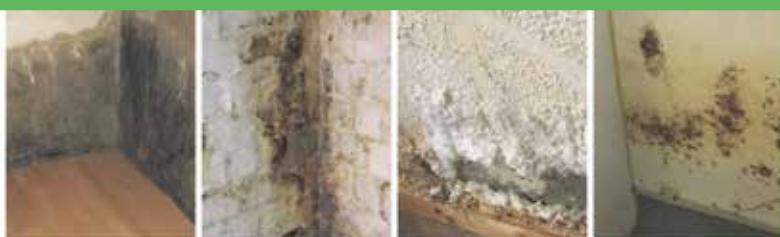
Defekte Horizontalsperre
