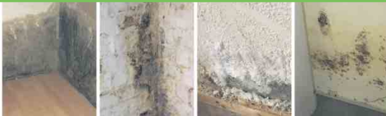
Defekte Horizontalsperre
