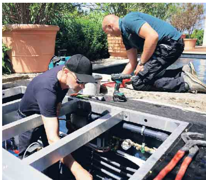
Arbeiten am Technischacht. Foto: Rambow Pooldesign/akz-o
