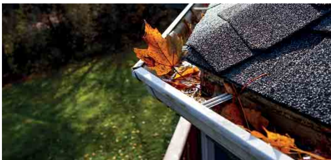
Reinigung der Dachrinne gehört auch zum DachCheck. Foto: soupstock/stock.adobe.com/akz-o
