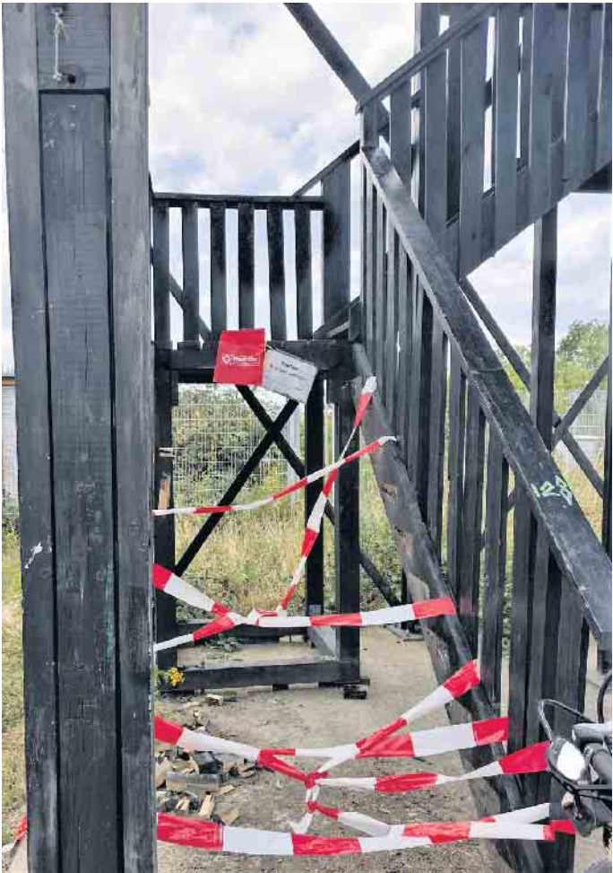
Der LSV hofft, dass die erneute Absperrung der Baustelle nicht wieder entfernt wird. Foto: Klaus Fietzek
