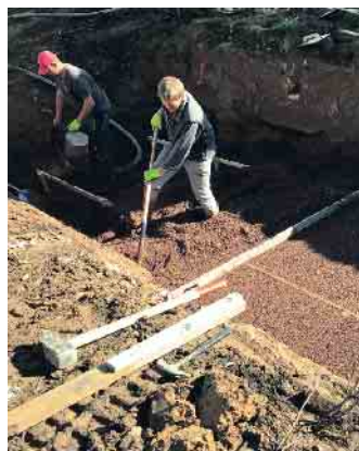
Basisarbeiten für das Becken. Foto: Gebr. Oehlbach/akz-o
