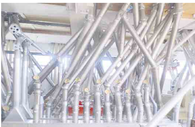
Zum Anlagenpark heutiger Mühlen gehört auch der Rohrboden, der die Verteilungszentrale und das Transportsystem für die verschiedenen Mahlerzeugnisse darstellt. Foto: djd/Bayerischer Müllerbund
