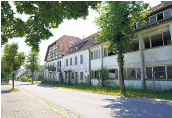
Auf dem Grundstück befindet sich ein umfangreicher Gebäudebestand der ehemaligen Molkerei.
