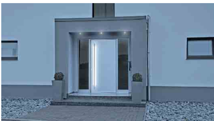
Haustür mit raffinierter LED-Beleuchtung. Foto: VFF/RODENBERG Türsysteme
