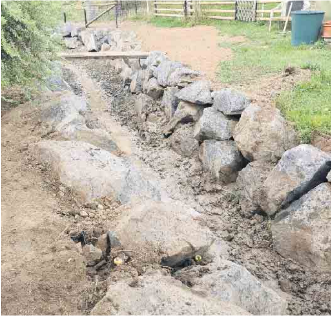
Zurzeit führt der Dreisbach noch Niedrigwasser. Die neuen Basaltsteine sind fest in die Erde eingesetzt. Fotos: C. Vogel
