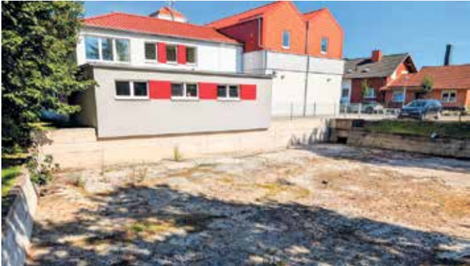
Um in der Wasserversorgung mehr Resilienz zu haben, soll in den nächsten Monaten der Löschteich hinter dem Gerätehaus der Feuerwehr saniert werden.
