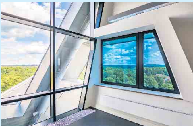
Mit Sonnenschutzgläsern lassen sich zusätzliche Kühl- und Verschattungsmaßnahmen reduzieren. Foto: EControl-Glas GmbH & Co. KG.
