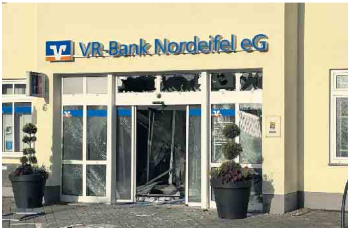
Erhebliche Schäden verursachte die versuchte Automaten-Sprengung in der Dahlemer VR-Bank-Filiale.
