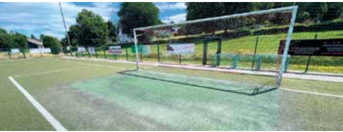
In einem Torraum wurde der Kunstrasenbelag ausgewechselt. © Gemeinde Dahlem
