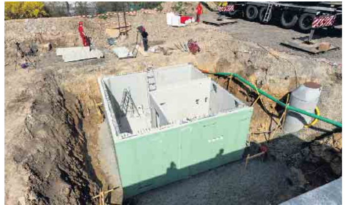
6,50 mal 6,50 Meter Baugrube reichen für einen kompakten Teilkeller meist schon aus. Foto: GÜF/Glatthaar Keller
