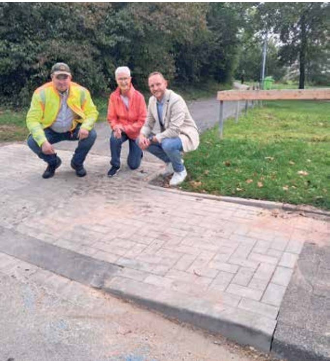
Von links: Niklas Wiegand (Tiefbauamt), Karin Rosemann und Baudezernent Florian Greger inspizieren die frisch angelegte Bordsteinabsenkung am sanierten Gehweg.
