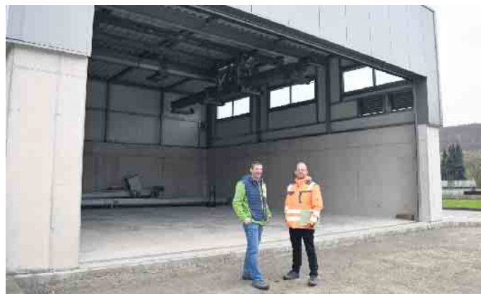
Von links: der Leiter der Kläranlage Thomas Adden und Betriebsleiter Sebastian Menne vor der neuen Schlammhalle.
