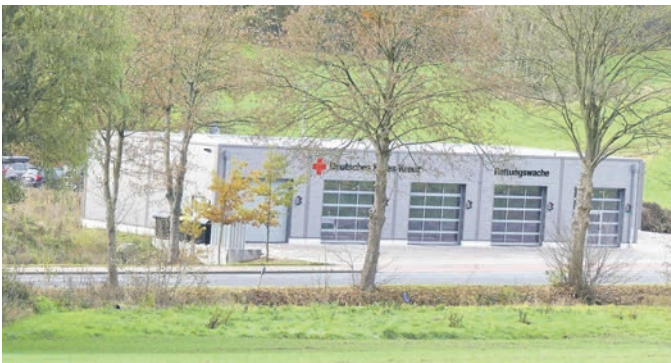
Die funktional und nach neuesten energetischen Vorgaben gebaute Rettungswache Ostercappeln mit den vier Sektionaltoren für die stationierten RTW (Rettungstransportwagen).
