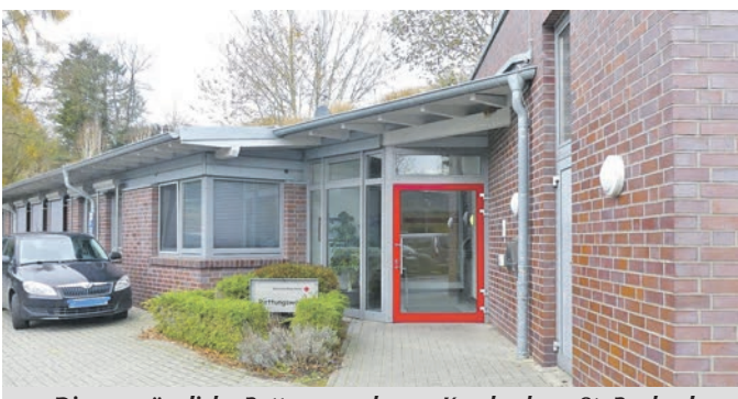
Die ursprüngliche Rettungswache am Krankenhaus St. Raphael in Ostercappeln, Bremer Str. 31.
