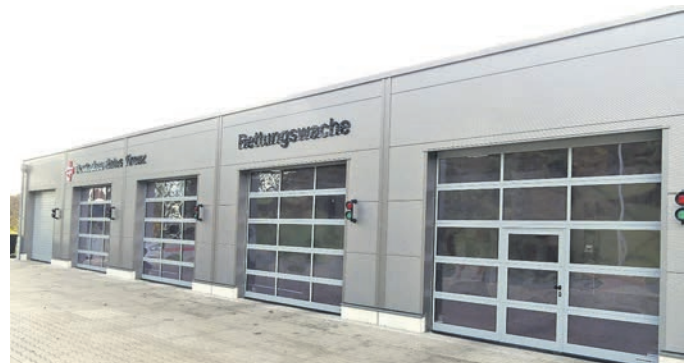
Hinter den Toren die Einsatzfahrzeuge.
