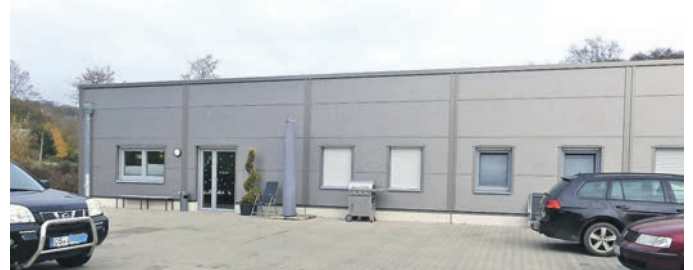
Auf der Rückseite der Rettungswache zur Ostseite mit den Fenstern für die Funktions- und Aufenthaltsräume und die Parkfläche für die Mitarbeiter.
