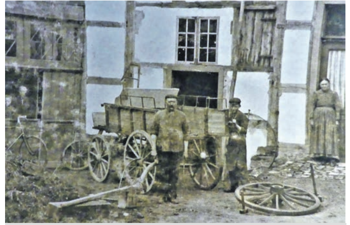
Ein sehr altes Foto zeigt den Schmied mit seinem Gesellen und der Frau des Hauses, wie ein hölzernes Wagenrad einen Eisenring erhält.
