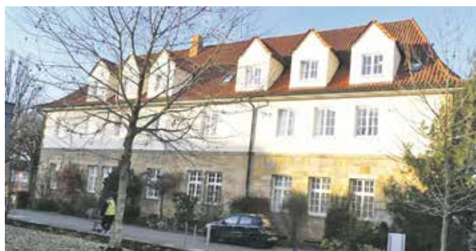
Das Rathaus Bohmte nach der letzten Erweiterung – zwei Vollgeschosse und ein Dachgeschoss mit Zwerghäusern, die Fenster sind symmetrisch angeordnet.
