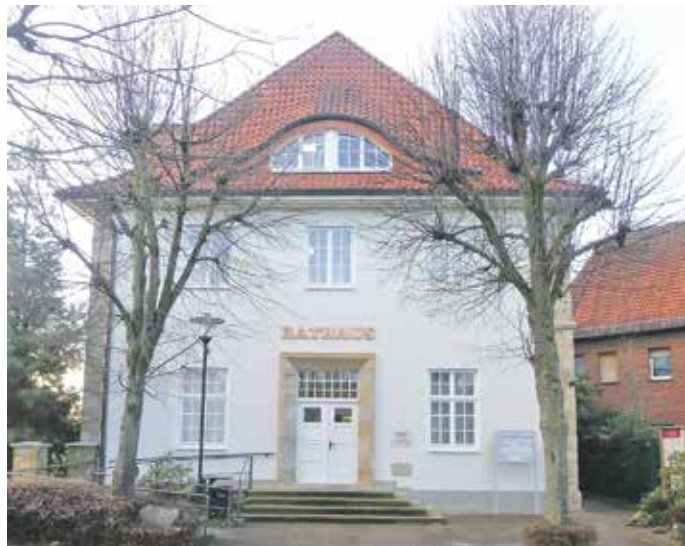
Die Rückansicht des Bohmter Rathauses, neben dem Treppenaufgang eine Rampe für Rollstuhl- und Rollator-Nutzung. Auch hier wie auf der Frontseite zwei gleichförmige Fassadenbäume
