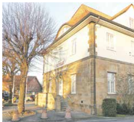
Die Frontseite des Bohmter Rathauses mit dem doppelstufigen Treppenaufgang und sichtbar – die Fassaden des Erdgeschosses sind aus Sandsteinquadern.
