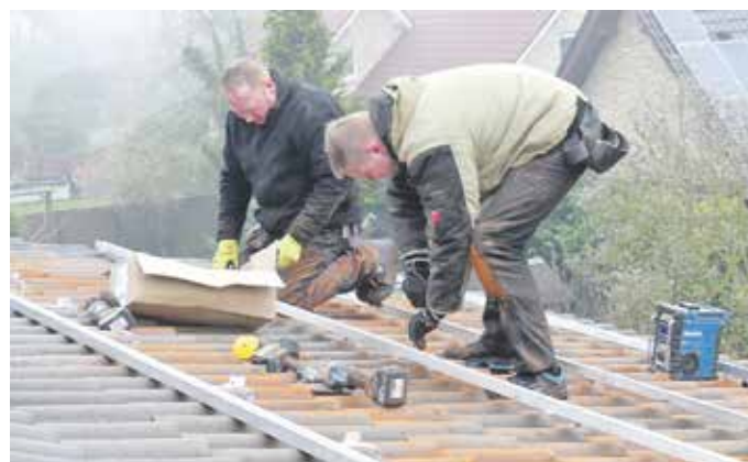
Die Schienen werden in der Stufe 2 an den Haken befestigt. Darauf kommen dann im 3. Arbeitsschritt die Module
