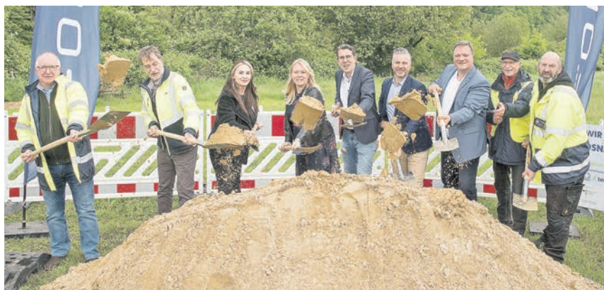
In der Gemeinde Bad Essen und in der Stadt Melle beginnt jetzt der Ausbau der Glasfasertrasse. Am Ersten Spatenstich beteiligten sich (von links) Wojciech Chwolka (Projektleiter Firma Fonbud), Andreas Tanger und Jessica Rotärmel (beide Landkreis Osnabrück, Stabsstelle Breitband), Bürgermeisterin Jutta Dettmann (Stadt Melle), TELKOS-Geschäftsführer Dirk Holtgrewe, Mario Aquino (Gebietsleiter GVG Glasfaser/teranet), Bürgermeister Timo Natemeyer (Gemeinde Bad Essen), Edmund Rade und Hannes Budschinski (beide Ingenieurgesellschaft Nordwest).
