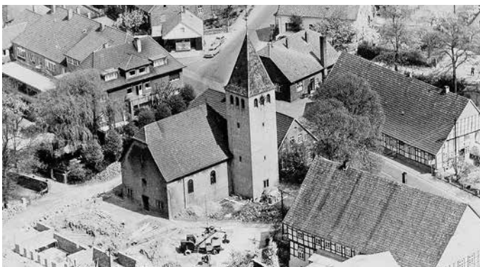
Das Bild zeigt die Kirche St. Johannes d.T. aus dem Archiv der Kirchengemeinde ca. 1960 beim Bau der Erweiterung. Damals gab es im Ortskern noch sehr viel Fachwerk.
