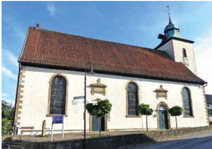
Die Christus-Kirche mit zwei Haupteingängen zur Nordseite und der Turm mit dem ausragenden Läutewerk
