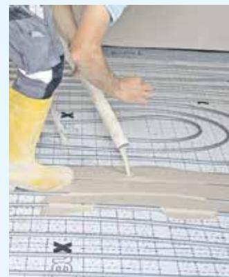
Nach der Vorbereitung des Untergrunds wurden die Heizrohre der Fußbodenheizung x-net C16 verlegt. Foto: Kermi GmbH/akz-o
