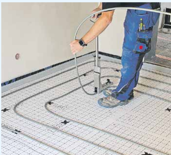
Nach der Vorbereitung des Untergrunds wurden die Heizrohre der Fußbodenheizung x-net C16 verlegt. Foto: Kermi GmbH/akz-o
