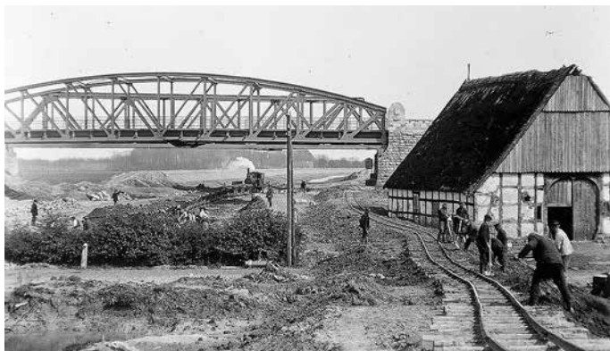
Kanalbau in Wehrendorf
