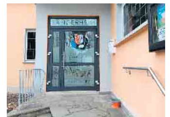
Die neue energetische Saaleingangstür des Sängervereins
