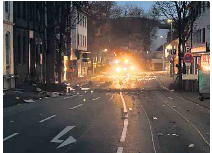
Reinigungsarbeiten des Bauhofs
