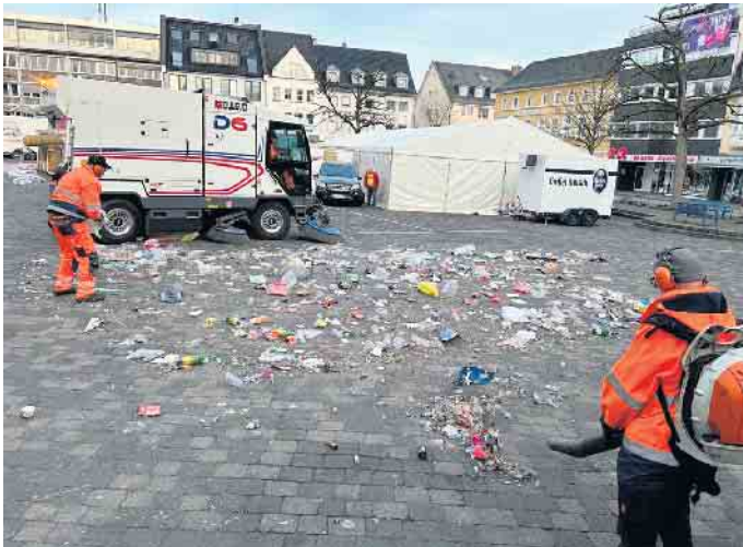
Reinigungsarbeiten des Bauhofs
