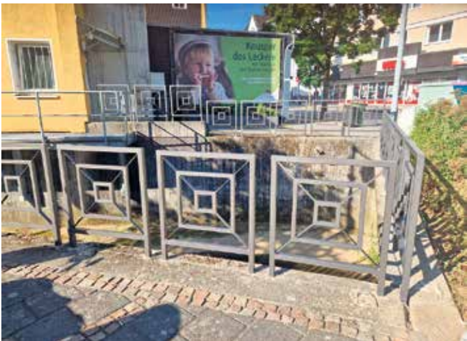
Geländer am Eipbach nach der Sanierung
