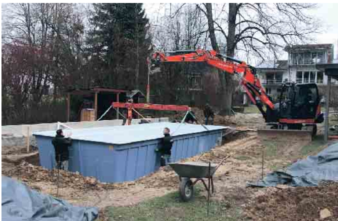
Teamwork auf der Baustelle. Foto: Schwimmbad Henne/akz-o
