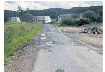
Die bisher eher einer Schlaglochpiste und Übungsstrecke für Geländefahrzeuge ähnelnde Strecke wird nun in einen vernünftigen Ausbaustand versetzt.
