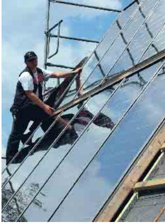
Photovoltaik: Dachdecker wissen, was zu tun ist. Foto: HF. Redaktion Harald Friedrich/akz-o
