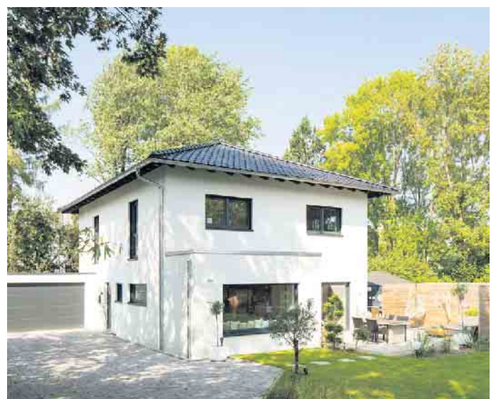
Die hohe Energieeffizienz moderner Holz-Fertighäuser hilft der Umwelt und spart Energiekosten. Foto: BDF/FingerHaus
