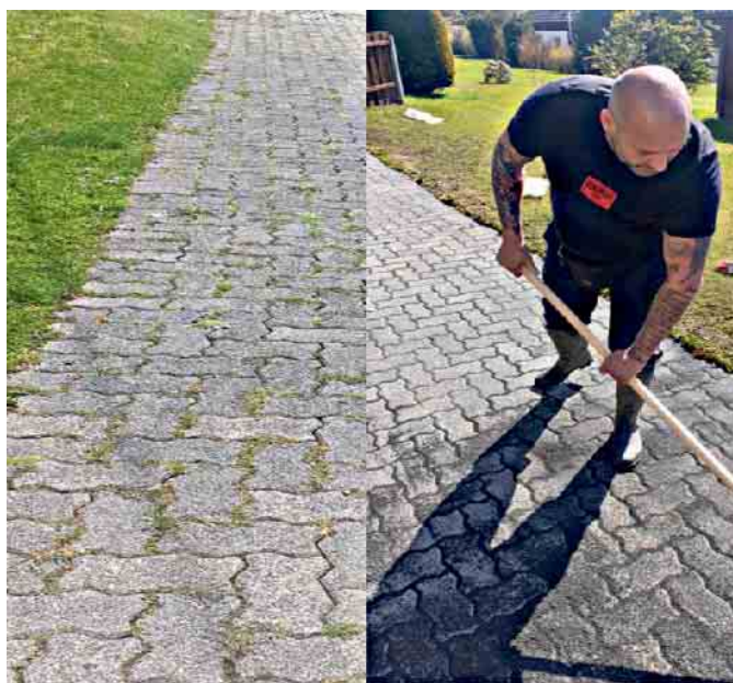
Reinigung von Fugen vorher und nachher.
