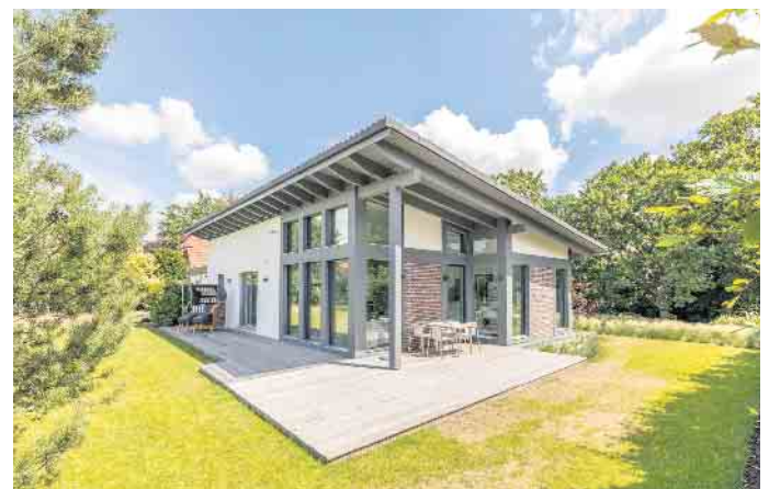
Fertighäuser werden nach den individuellen Wünschen und Bedürfnissen des Bauherrn geplant - vom kompakten Bungalow bis hin zur großen Stadtvilla. Foto: BDF/Meisterstück-HAUS
