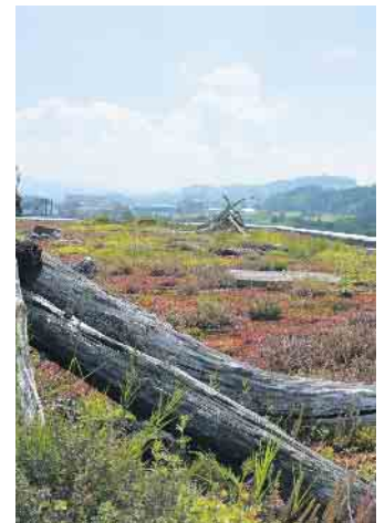
Die Begrünung von Flachdächern trägt zu einem besseren Mikroklima bei. Foto: djd/Paul Bauder
