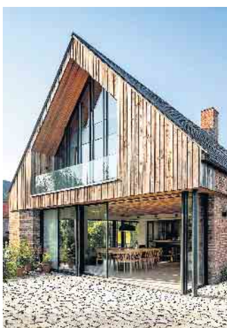
Gegen die Flächenversiegelung: Versickerungsfähige Pflastersteine ermöglichen es, dass Regenwasser abfließen kann. Foto: DJD/betonstein.org
