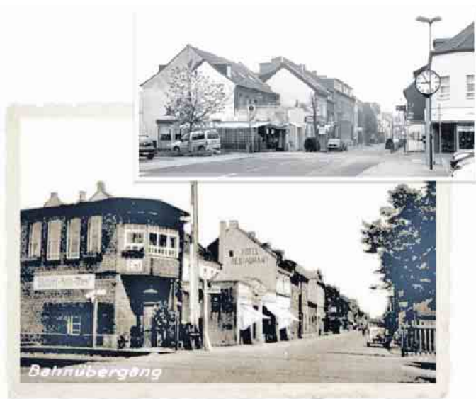
Bahnübergang Köln-Aachener Straße
