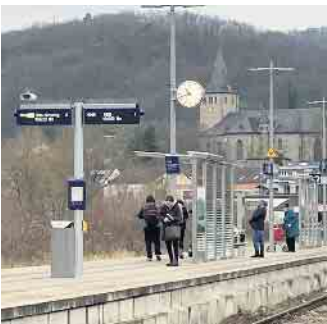
Überdachung auf dem Bahnsteig in Engelskirchen
