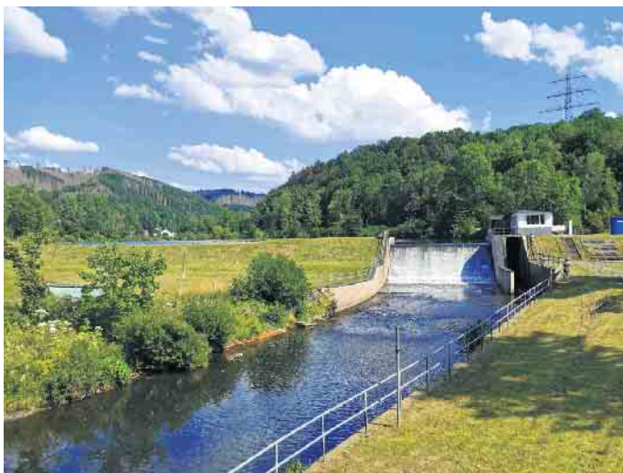
Kurz vor der Staustufe wird links ein Kanal die Wanderfische im großen Bogen nach oben führen.
