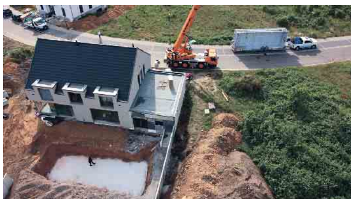
Per Kran wird das Becken eingesetzt. Foto: Vogel Pool/akz-o
