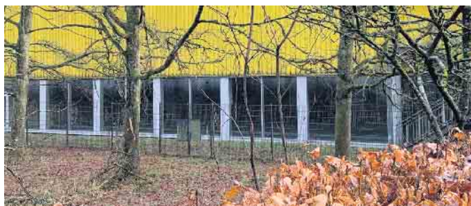
Hallenbad im Untergeschoss der Sporthalle Walbach
