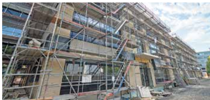
Am Friedrich-Ebert-Gymnasium entstehen unter anderem ein Erweiterungsneubau mit 19 Klassenräumen sowie eine Mensa mit Foyer.
