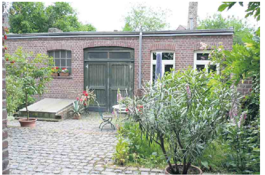
Ehemalige Dampf-Weinbrennerei Fausten.
