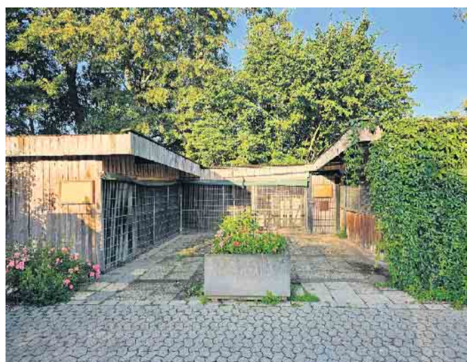
Die Vogelvoliere im Schwingbodenpark: Der Abriss beginnt.
