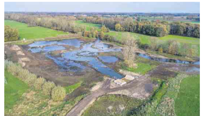
Stauraum bei Hochwasser in der naturnah umgebauten Niers
